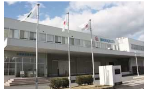
本社工場の外観
